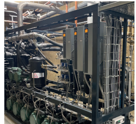
▲▲ Cette centrale de froid CO 2 occupe deux fois moins de place au sol que les anciennes générations.
