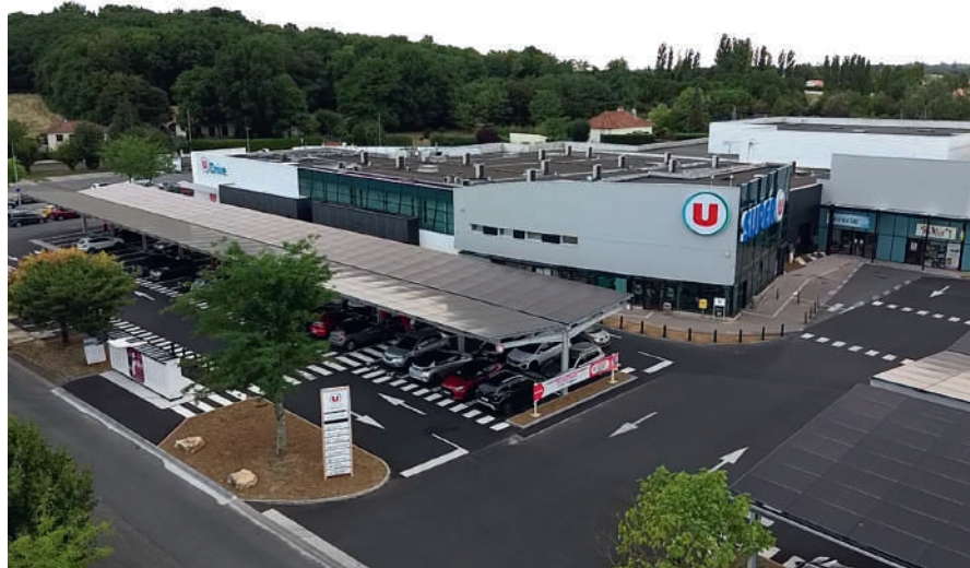
▲ Développ'Sun a déployé 2000m 2 d'ombrières sur le parking du Super U de Sauze-Vaussais (Deux-Sèvres, photo du haut) et a aussi couvert le parking du Super U de Saint-Georges-lès-Baillargeaux (Vienne).
