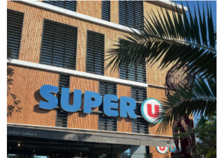
▲ Des persiennes inclinables protègent les fenêtres exposées au soleil.
